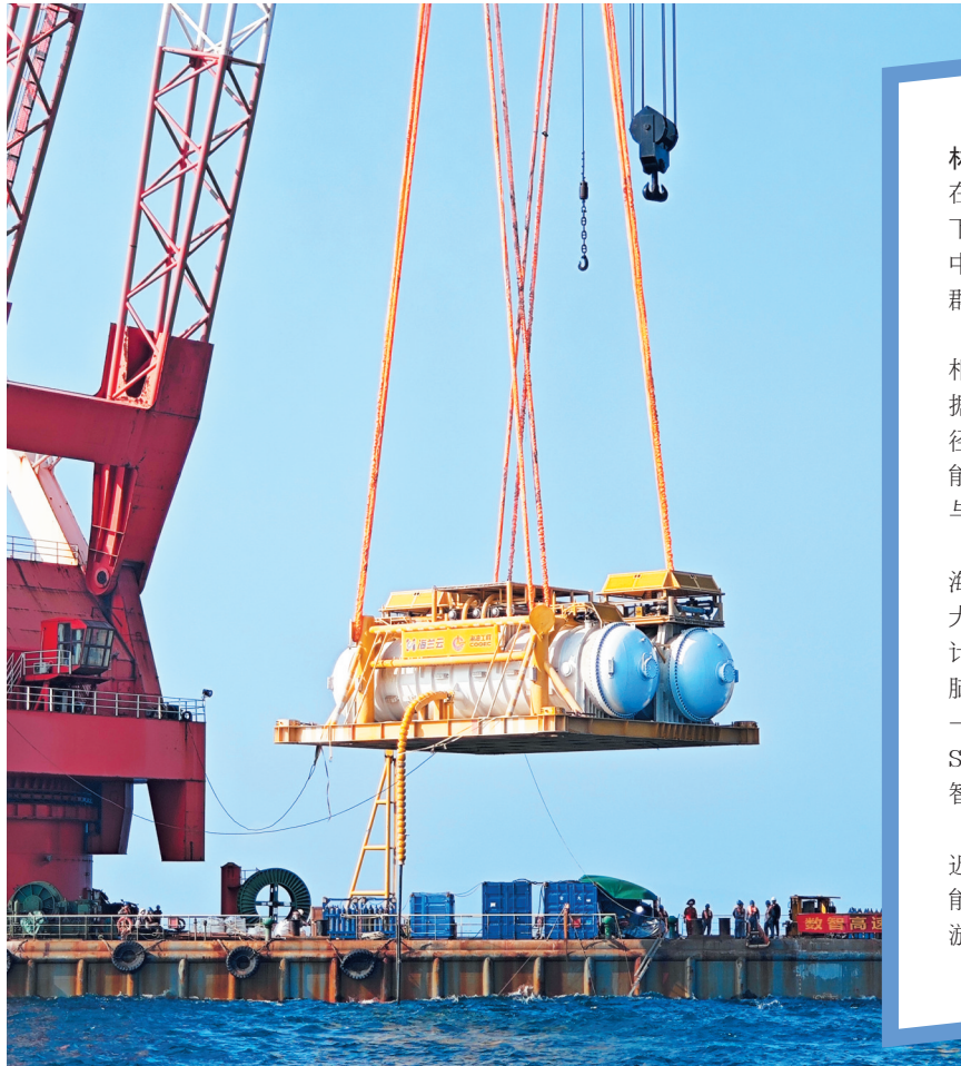
海南海底智算中心集群启用。(海底数据中心示范开发项目供图)
