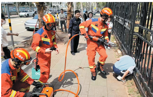
消防人员使用专用工具扩张和破拆围栏。
