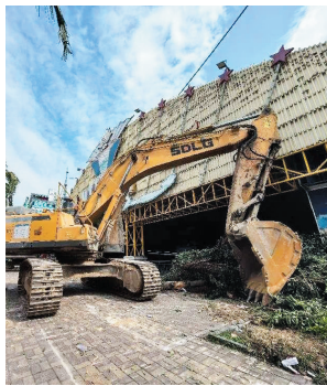
三亚春园海鲜广场依法拆除工作正在进行。
