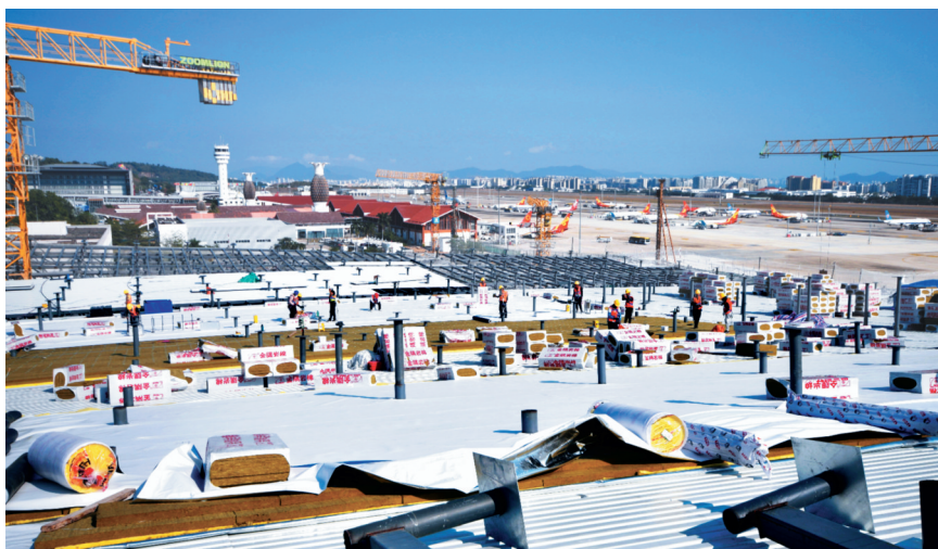
三亚凤凰国际机场三期施工现场。（三亚凤凰机场供图）
