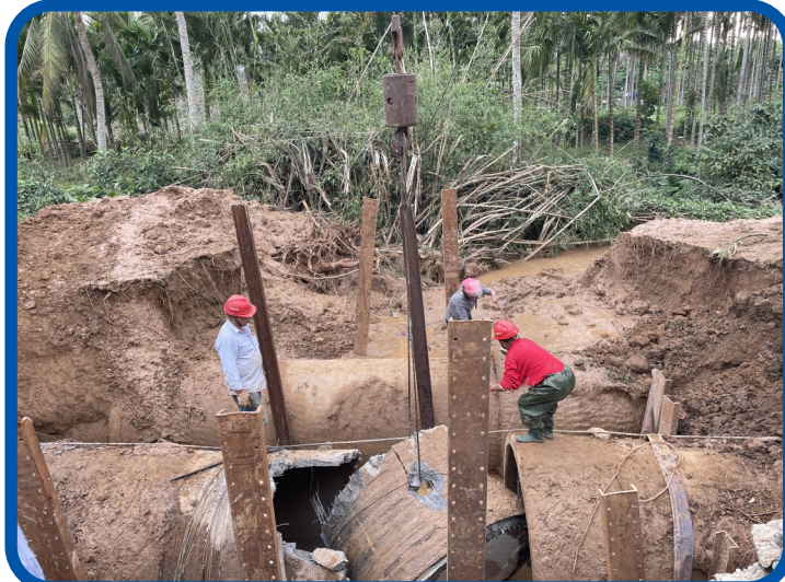
拆除破损管道。(记者 叶长文摄)
