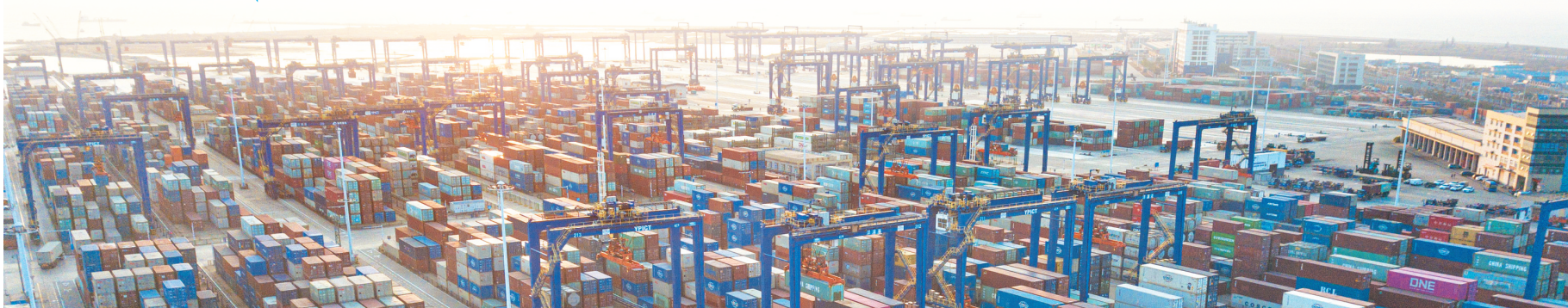
2025年1月11日在海南洋浦经济开发区拍摄的洋浦国际集装箱码头(无人机照片)。(新华社记者 蒲晓旭 摄)
