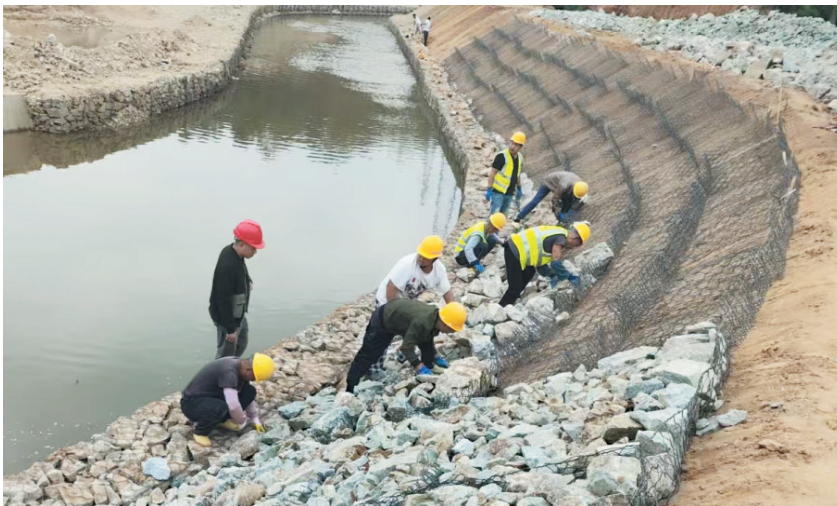
屯昌山洪灾害防治项目建设现场。(屯昌水务局供图)
