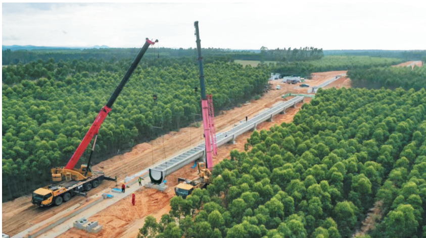
琼西北供水工程建设现场。(受访者供图)
