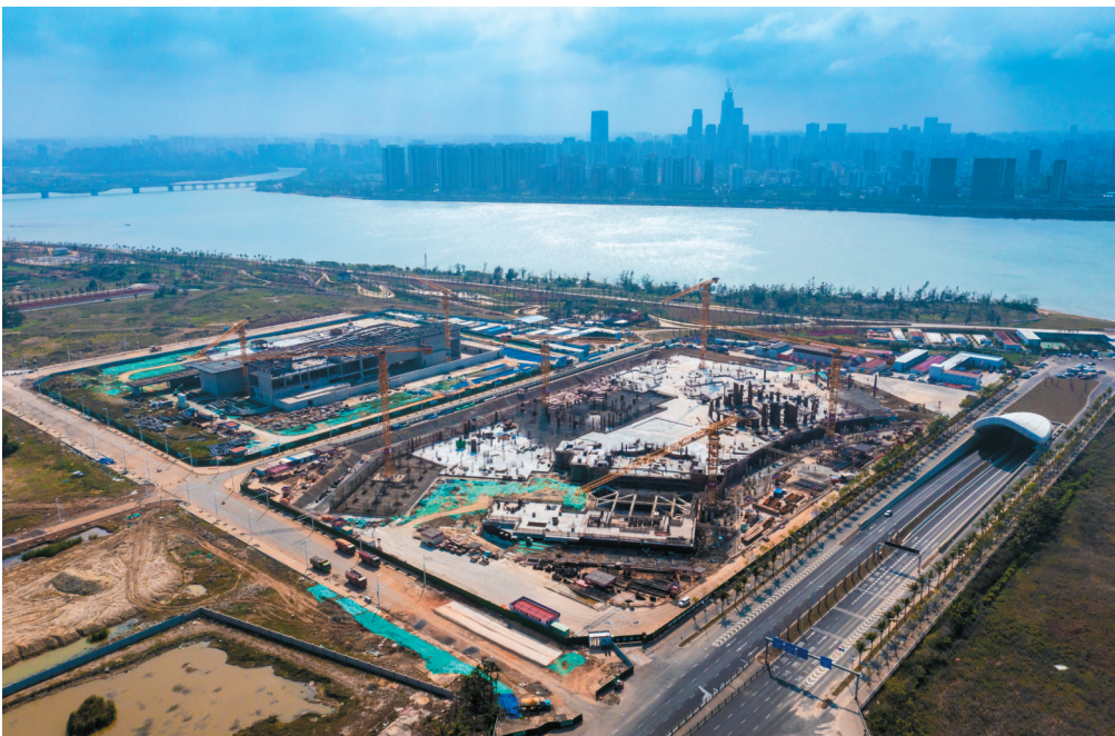
2月28日,俯瞰正在建设的海南省艺术中心(演艺中心)项目。记者 李昊 摄
