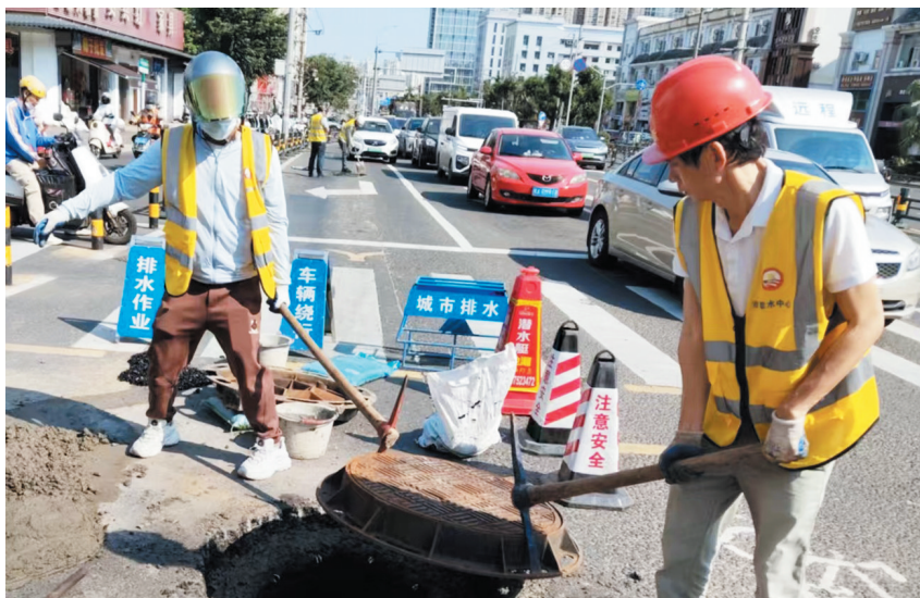
排水部门工作人员对井盖进行抬升修复。
