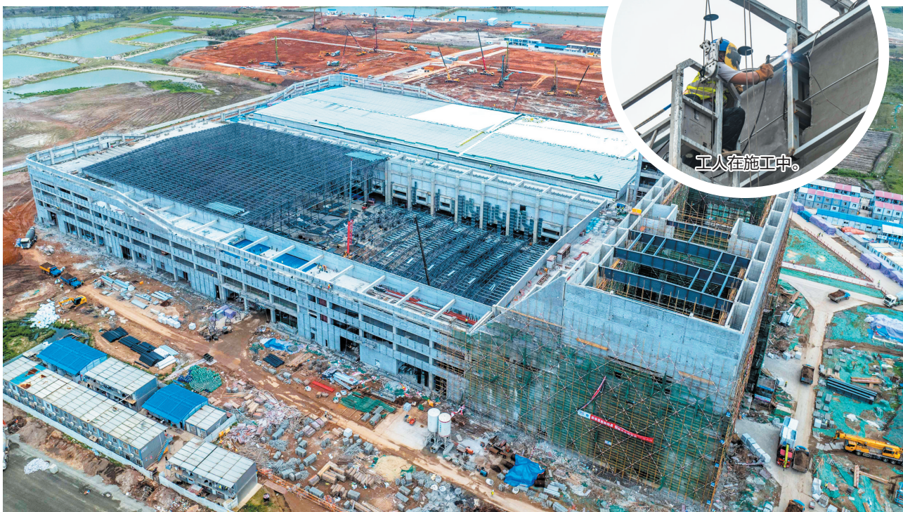
海南卫星超级工厂项目建设施工现场。
