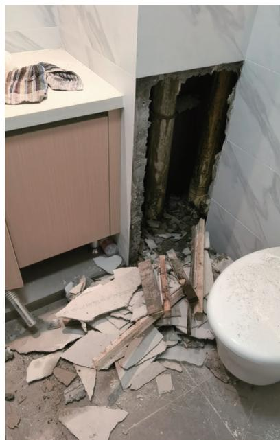
一层卫生间漏水后敲开墙面进行维修。
