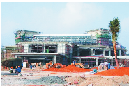
2003年1月,正在建设中的博鳌亚洲论坛国际会议中心。 特约记者 蒙钟德 摄
