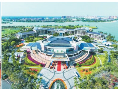
2025年3月23日,博鳌亚洲论坛国际会议中心。海报集团全媒体记者 袁琛 摄
