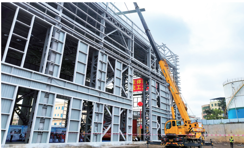
封板吊装作业现场。记者 路静 摄
