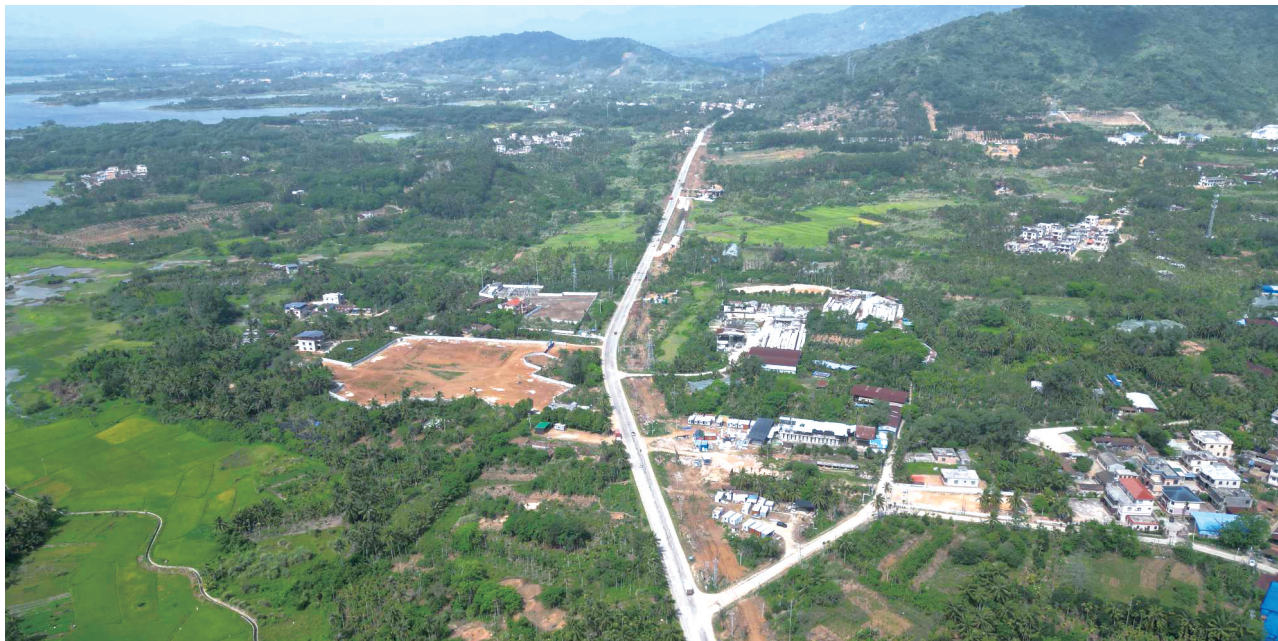
国道G223万宁市长丰至兴隆段正在改建施工。
