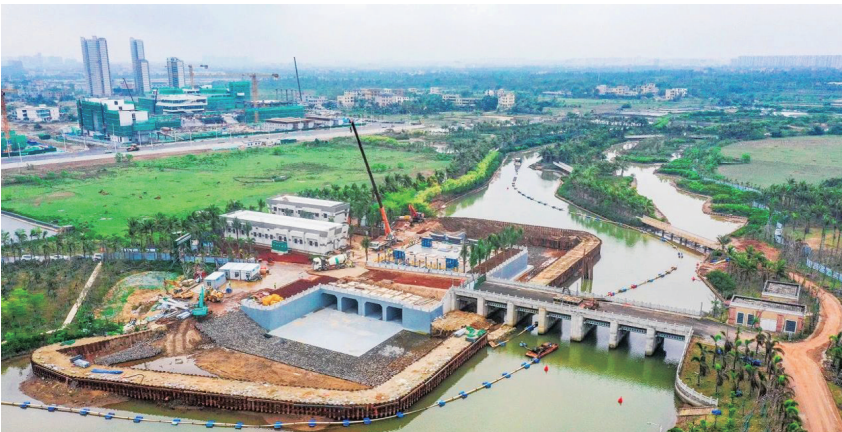
项目施工现场。海口江东新区管理局供图
