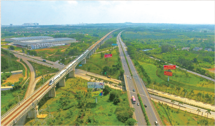
海南西线环岛高速和高铁。
