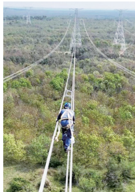
海南电网员工对昌江核电二期接入系统工程输电线路开展巡检。通讯员符永新 摄
