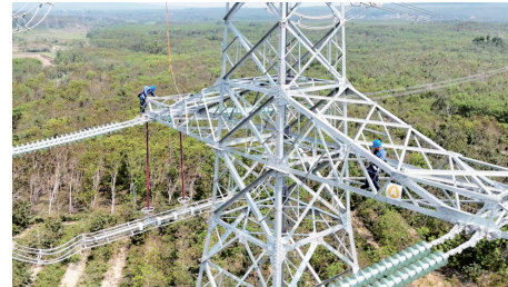
海南电网员工对昌江核电二期接入系统工程输电线路开展巡检。通讯员符永新 摄
