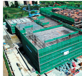
海南咨询设计产业基地项目施工现场。（受访者供图）
