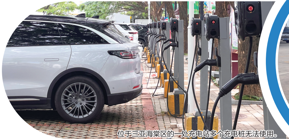
位于三亚海棠区的一处充电站多个充电桩无法使用。
