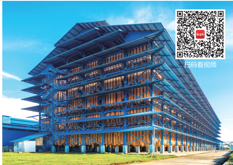
海南橡胶下属合盛农业印度尼西亚橡胶加工厂。(海南橡胶供图)
