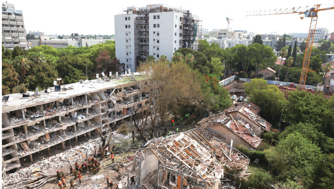
6月22日在以色列特拉维夫拍摄的在导弹袭击中被损毁的建筑。新华社/路透
