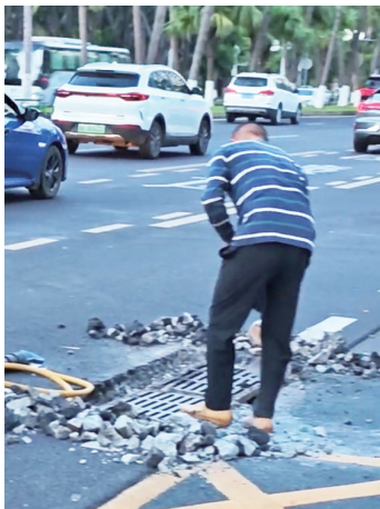
海口滨海大道上,工人正对不平的井盖实施作业。
