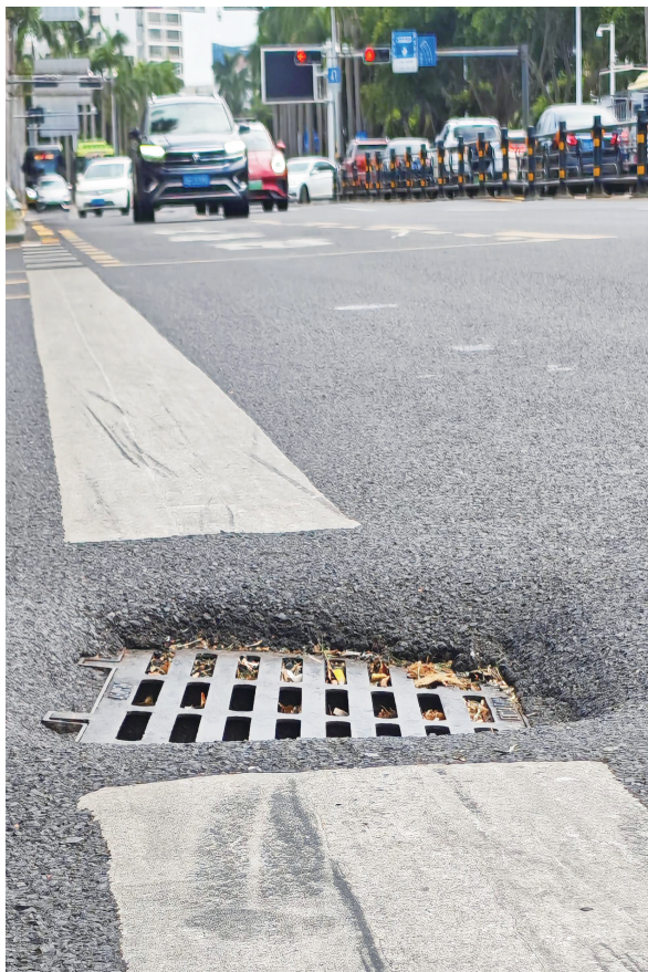
海口海府路上新铺设沥青路未同步抬升的井盖。海口南海大道一处非机动车道路面开挖后简单使用沥青回填。
