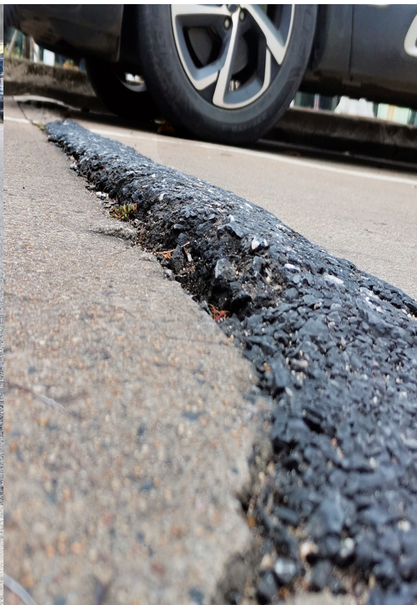
海口海府路上新铺设沥青路未同步抬升的井盖。海口南海大道一处非机动车道路面开挖后简单使用沥青回填。
