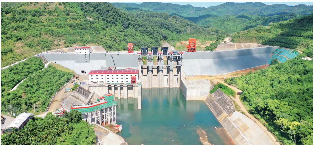
迈湾水利枢纽工程主坝。（受访单位供图）
