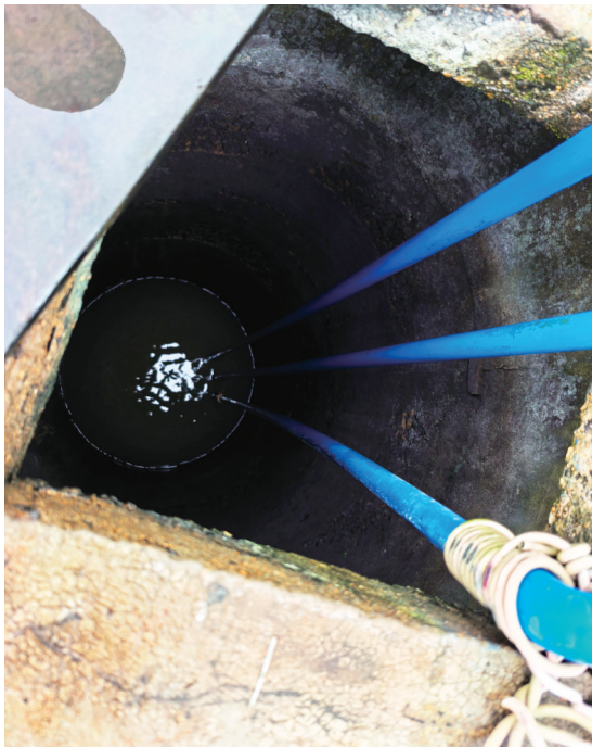
水井里布置多条水管抽水供村民日常使用。
