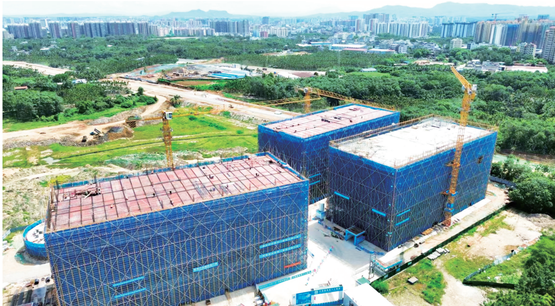
琼海富海产业园区内的标准厂房一期工程封顶。
