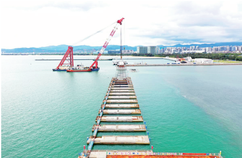
三亚深海科考码头项目沉箱安装完成。通讯员 罗仕林 摄
