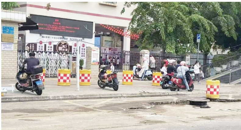
市政维修人员及时将“张嘴”井盖盖上。
