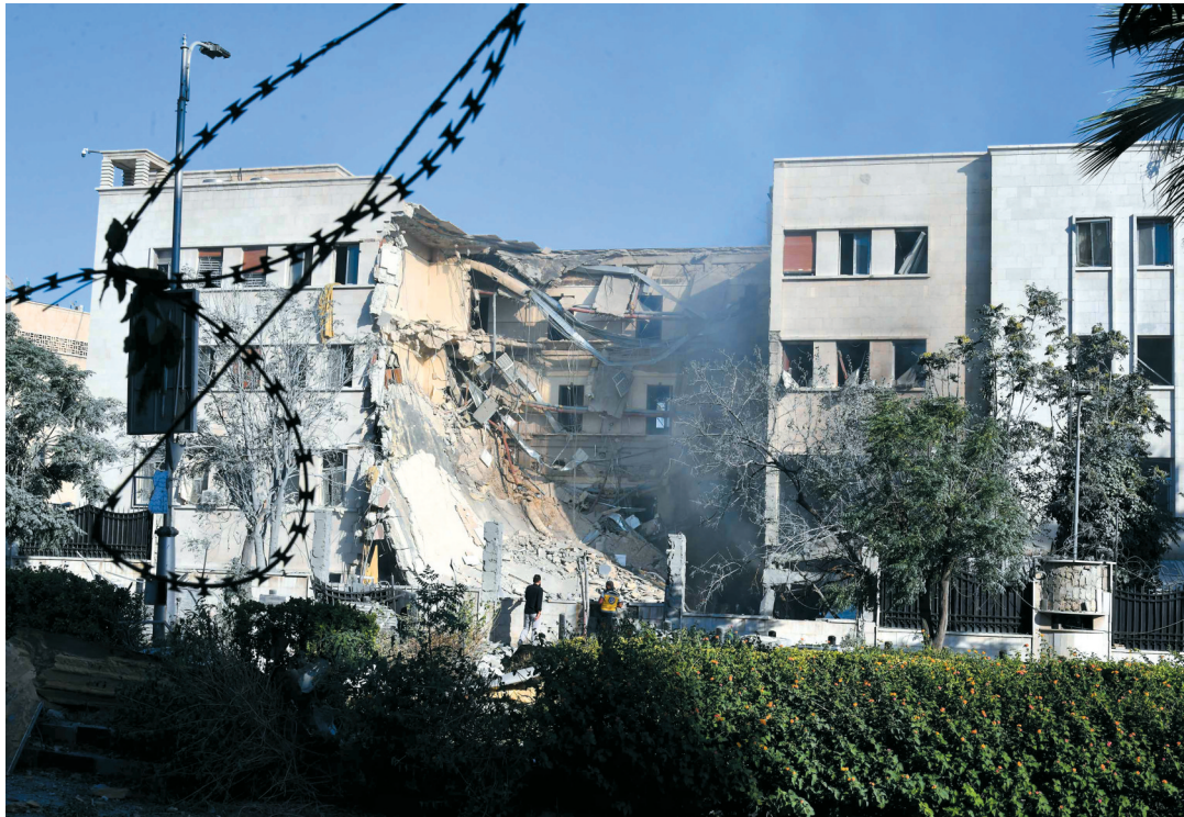
7月16日在叙利亚首都大马士革拍摄的在以色列空袭中受损的叙“总参谋部”大楼。 新华社发(阿马尔·萨法尔贾拉尼摄)
