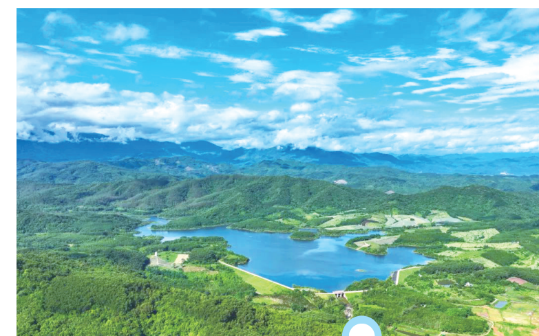
细水坡生水库
