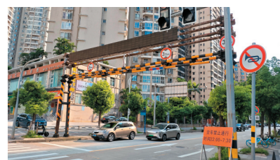
港爱路路口安装了限高架。
