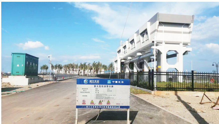
潭览河泵站。记者 李文韬 摄
