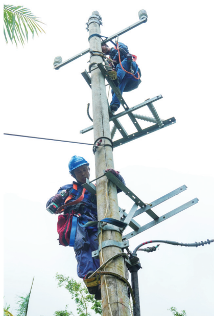
供电人员在三亚凤凰路抢修线路。海南日报全媒体记者 千程龙 摄
