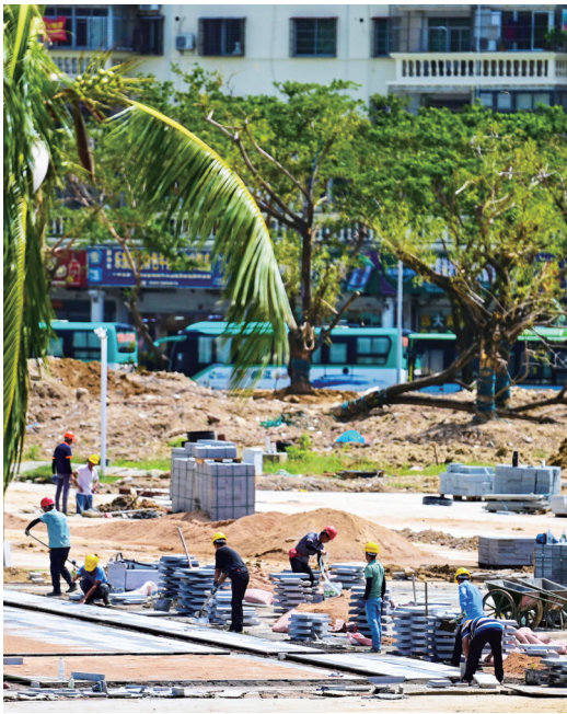
27日,三亚湾一处工地复工复产。记者 沙晓峰 摄
