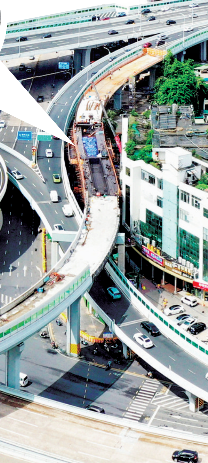
9月1日,记者航拍海口海秀快速路龙昆南匝道完善工程项目施工现场。
