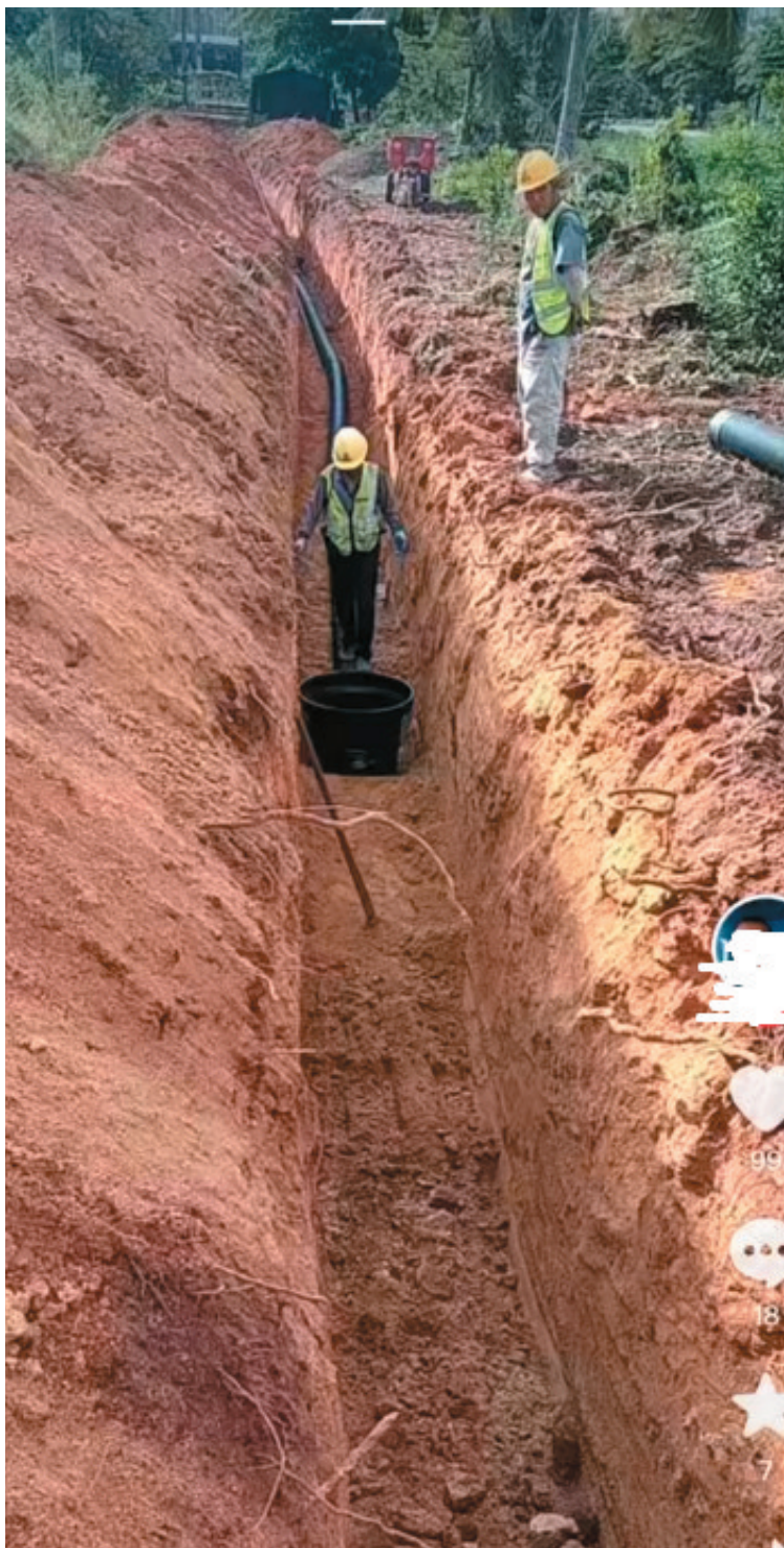
施工现场。（村民供图）
