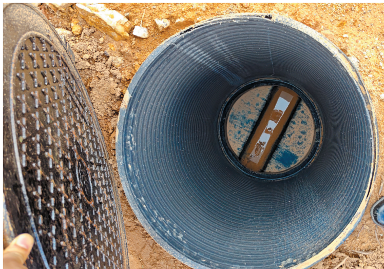
铺设的排污管口径为200mm。
