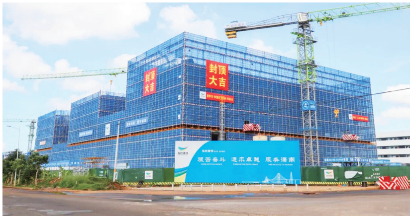
海医桂林洋新校区项目(二期)首栋单体建筑封顶。海口江东新区管理局供图
