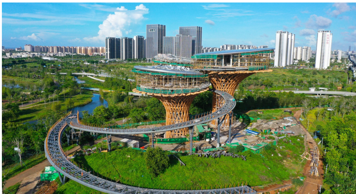
“雨林之心”独特的“巢”状遮阳屋顶已完成大半装饰工作。
