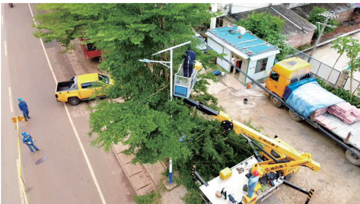
海南电网工作人员清理树障。通讯员 许家俊 摄
