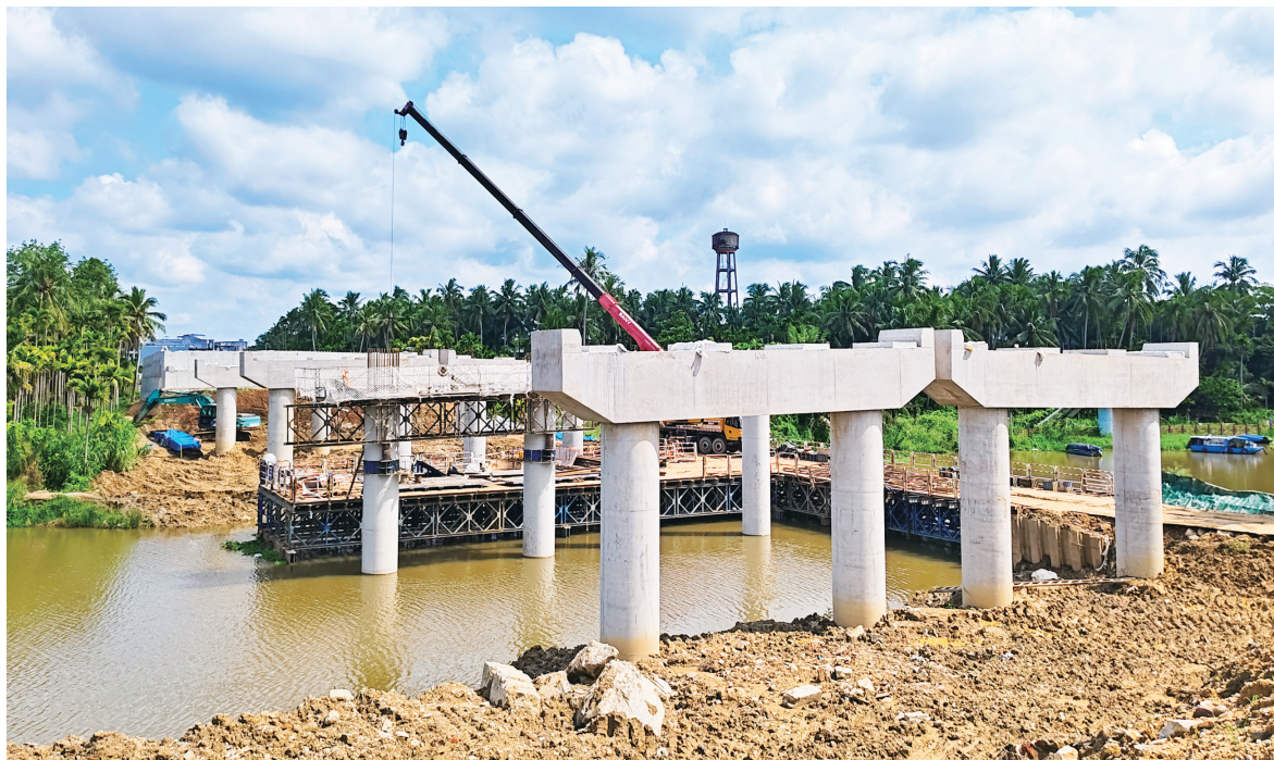
在建中的万泉镇文曲新桥项目。
