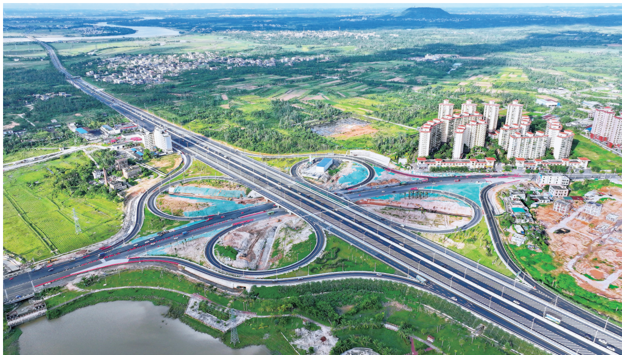
10月7日,位于定安县定城镇的G98环岛高速仙沟互通改造项目实施进入收尾阶段。(通讯员 程守满 摄)
