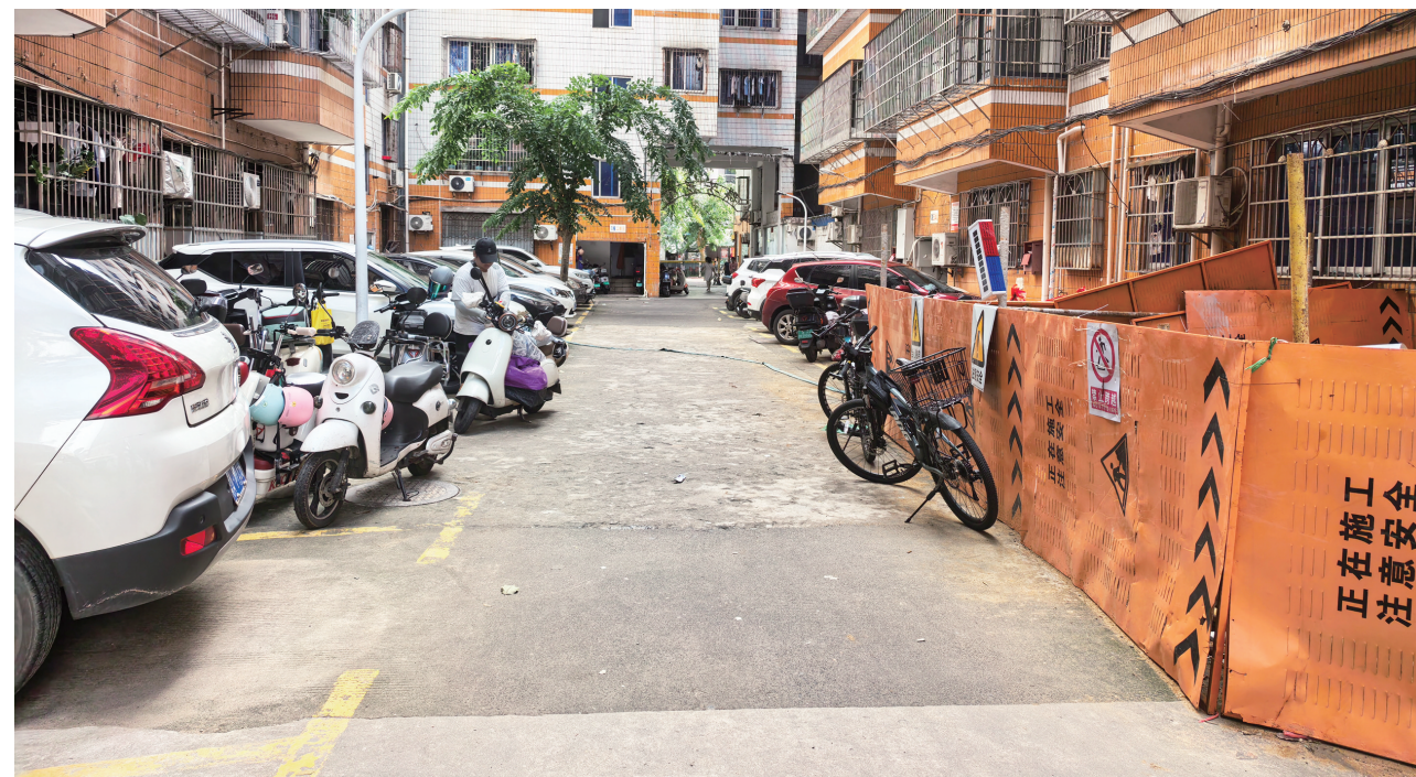
施工区域占用部分空间后,小区通道显得更加拥挤。
