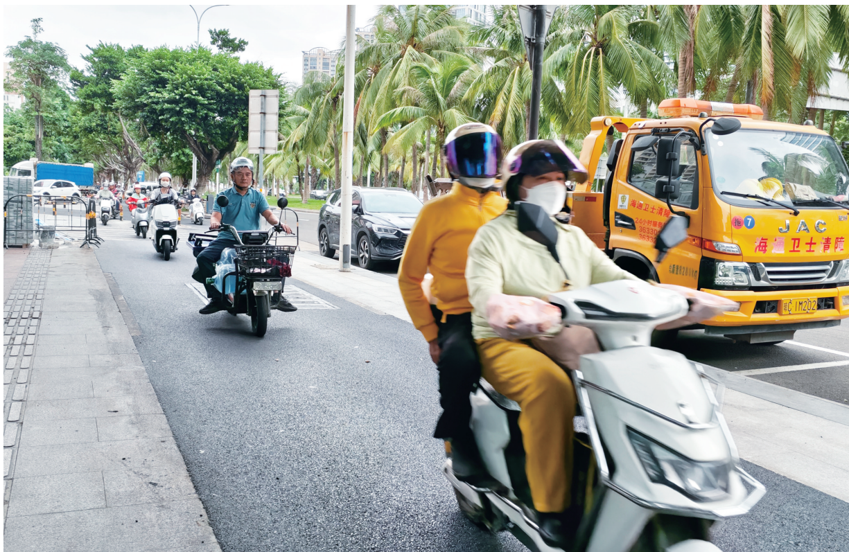
海口龙昆南路昆坡路路口至海口市人民医院龙昆南门诊部路段完成人行道改造。
