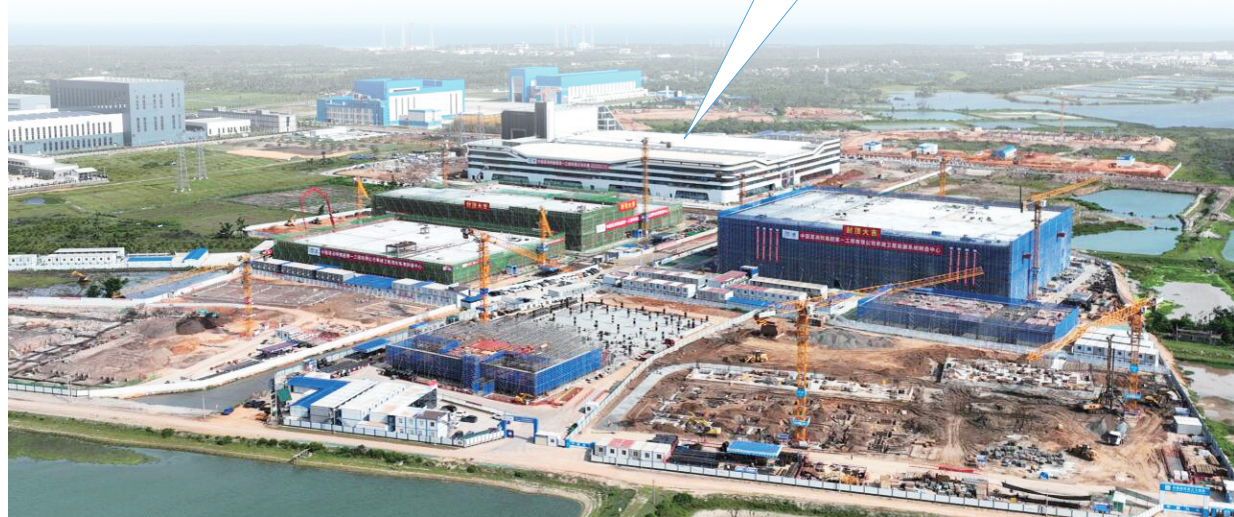
文昌国际航天城火箭卫星产业集群。(建设方供图)
