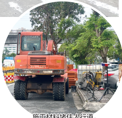
施工材料堵住人行道。
