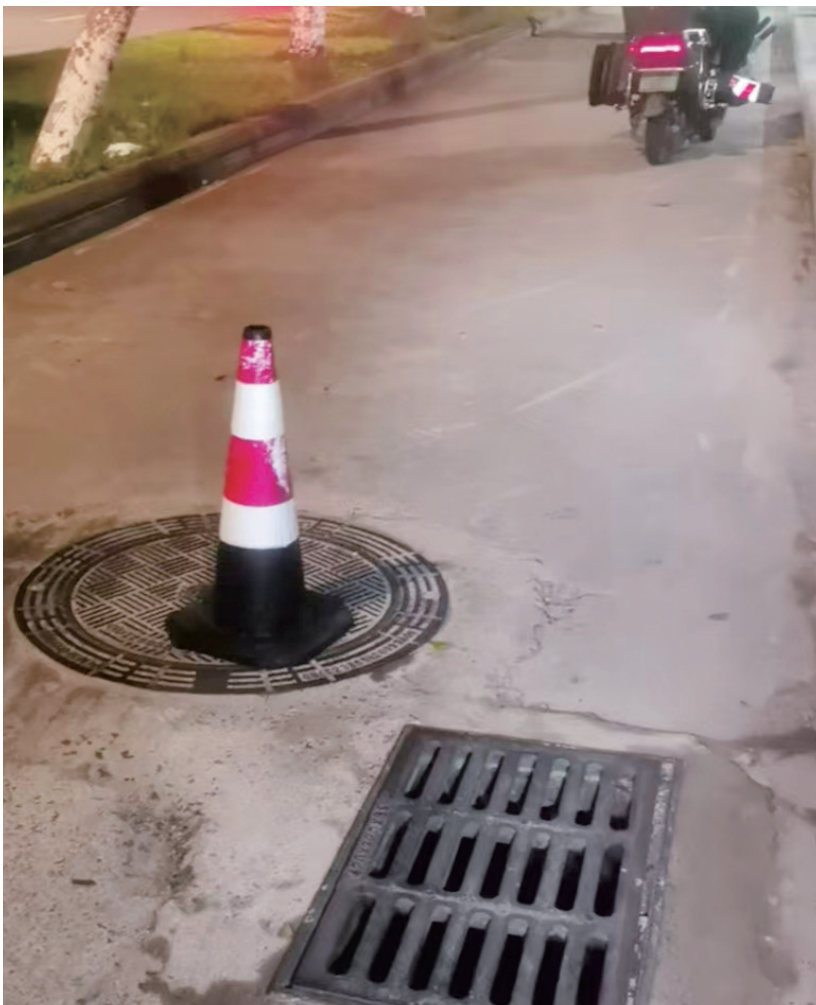
临时修复的井盖及周边路面。(海口市市政工程维修公司供图)
