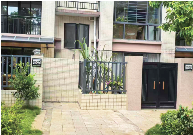
金岛海一方小区一楼多户业主砌墙圈占公共区域。
