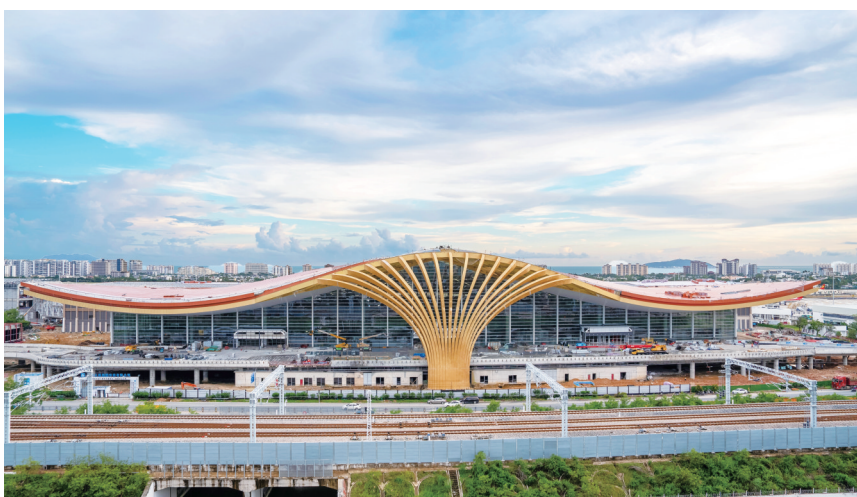
凤凰三期项目T3航站楼。海南机场集团供图
