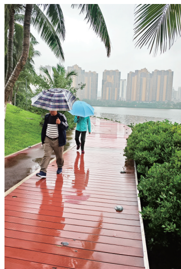
完成修复的漫步道。
