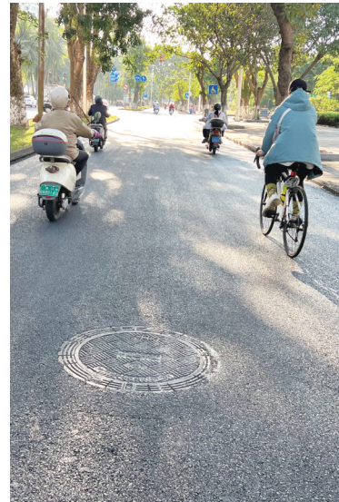
滨海大道非机动车道井盖与路面齐平,提升通行体验。
