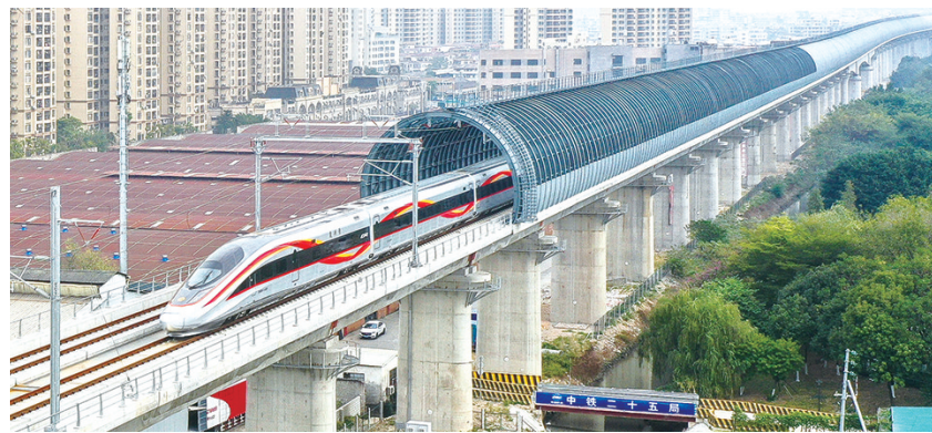
12月22日，广湛高铁列车穿过高中立交特大桥“隔音隧道”。新华社发
